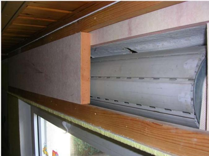
**Hochleistungsdämmstoff WLG 021
